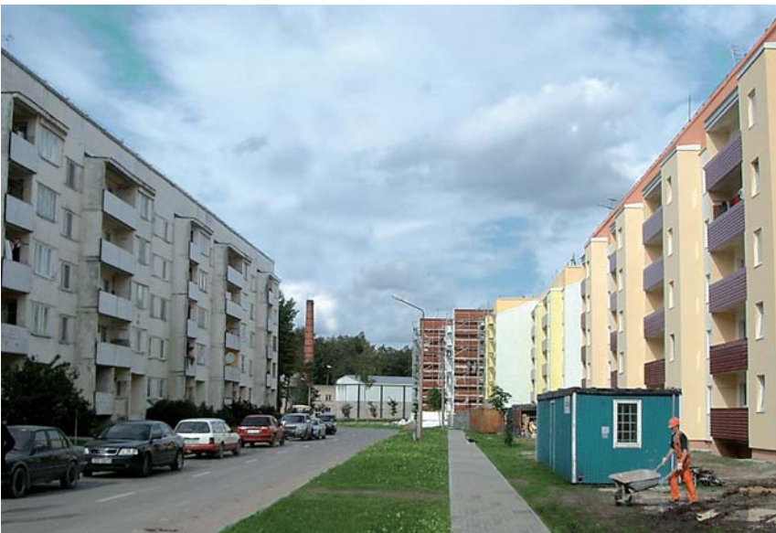
Broceni, Saldus Region: Abschluss der Sanierungsarbeiten in der Skolas Str. im Herbst 2004
