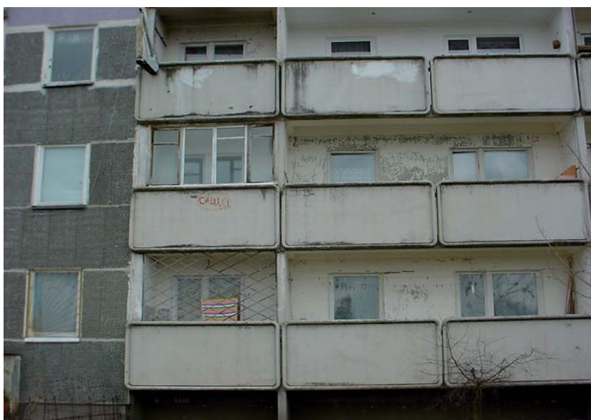
Lielpaneļu nama detaļa Jelgavā 2003. gadā
