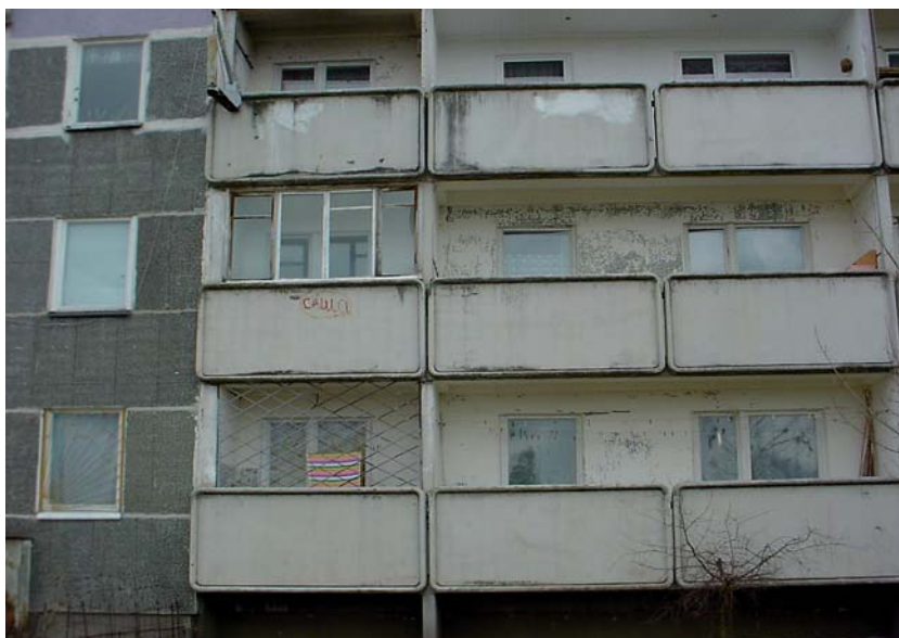
Lielpaneļu nama detaļa Jelgavā 2003. gadā
