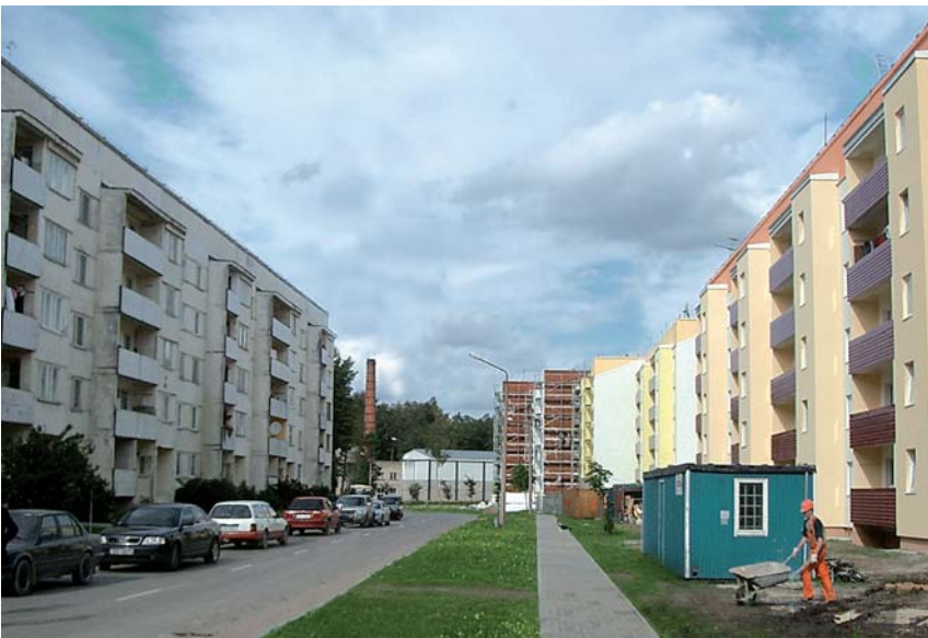
Broceni, Saldus Region: Abschluss der Sanierungsarbeiten in der Skolas Str. im Herbst 2004
