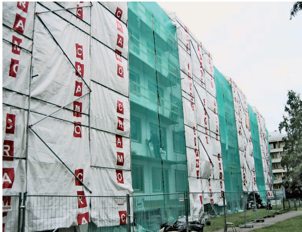
Energetische Sanierung eines Plattenbaugebäudes in Tallinn, 2007
