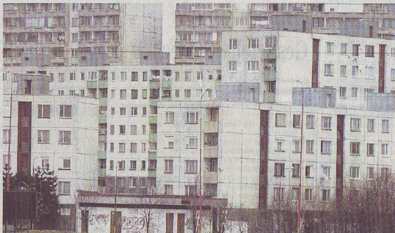
In Osteuropa hofft man, mit Hilfe von EU-Geld die Plattenbauten sanieren zu können.
