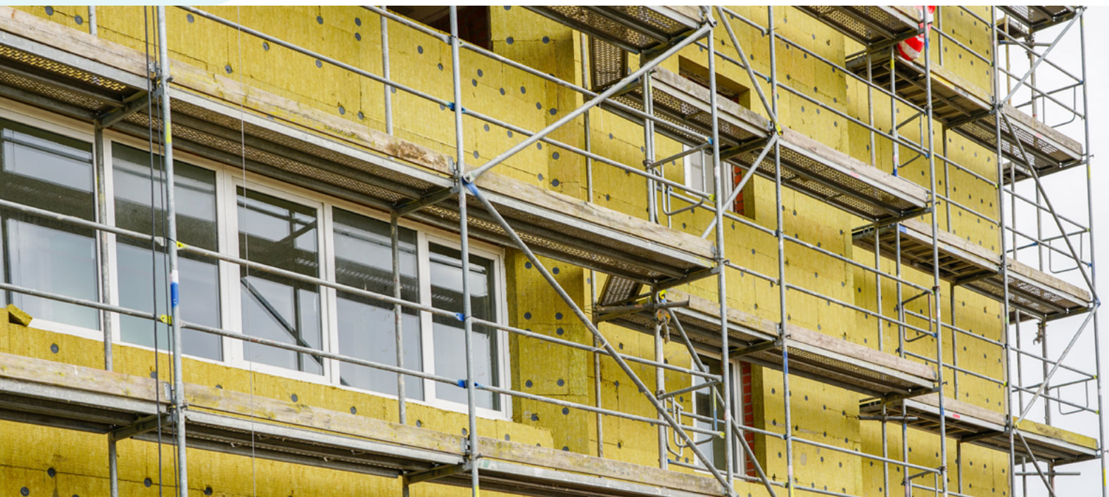
Термомодернизация жилого дома
