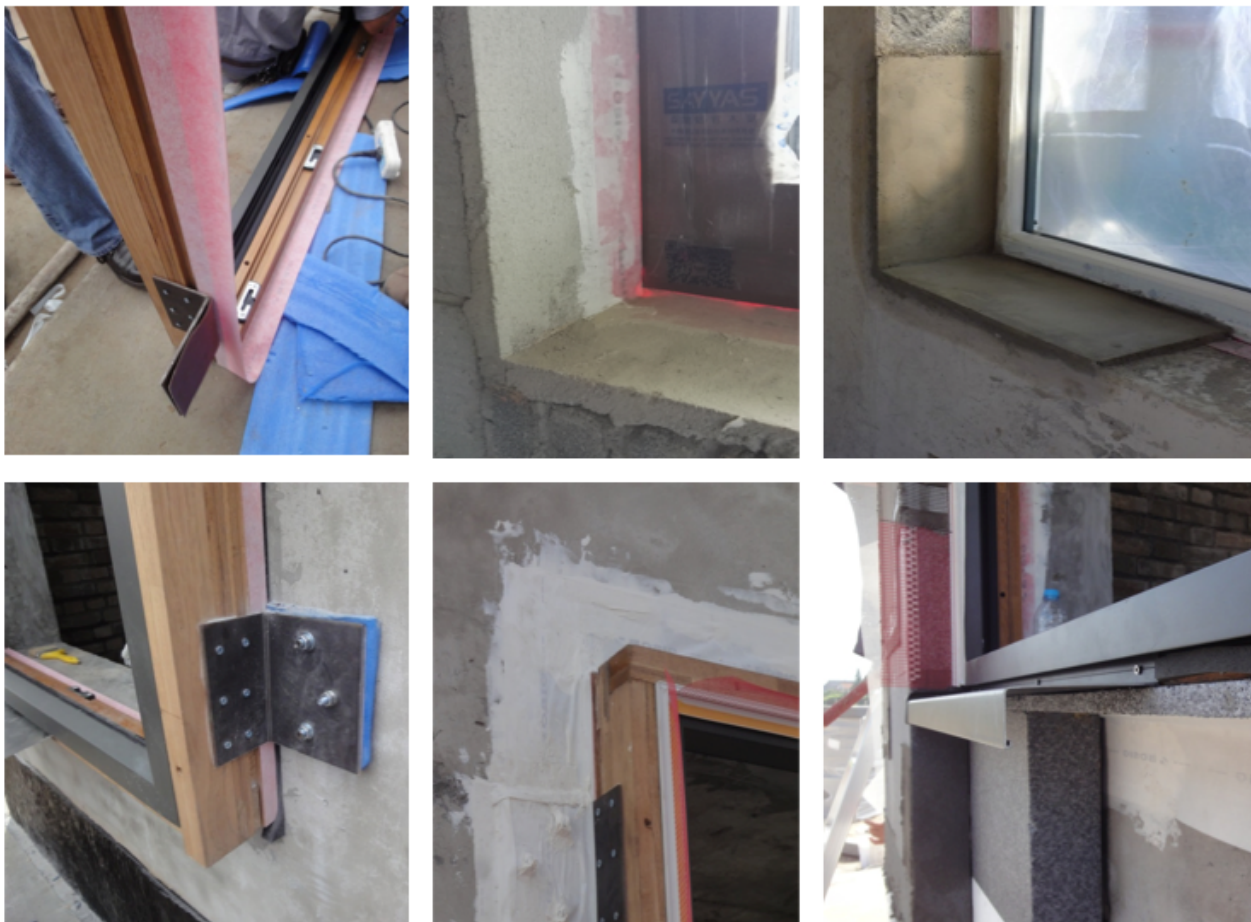
Уплотнение оконной рамы
