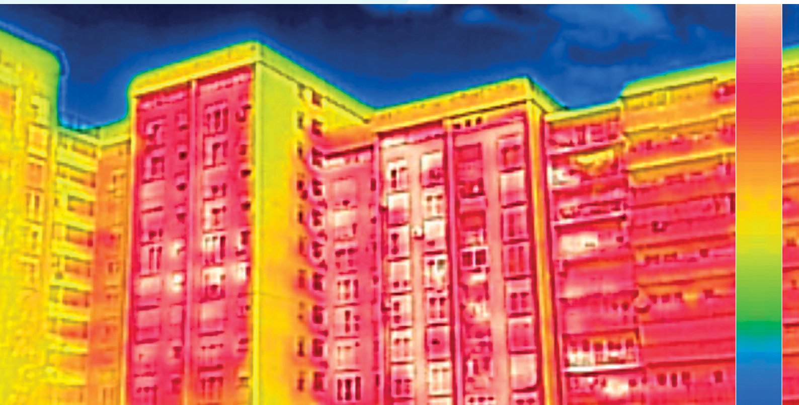
Тепловізійний знімок багатоквартирного житлового будинку після модернізації © shutterstock
