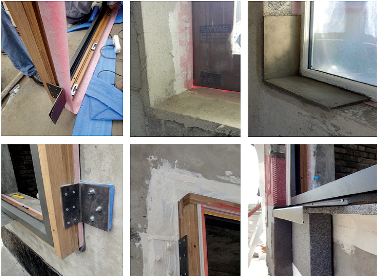
Ущільнення віконної рами © dena
