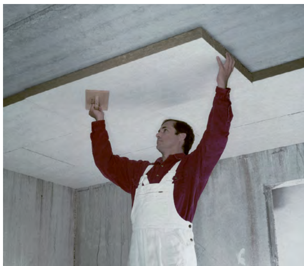
Рисунок 22: Теплоизоляция потолка подвального помещения
