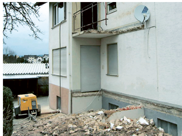
Рисунок 27: Снос балконной плиты
