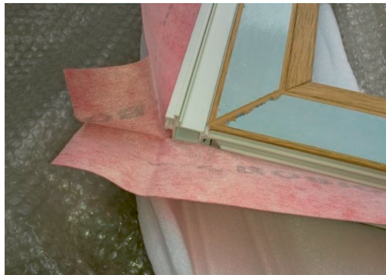
Рисунок 8: Воздухонепроницаемая лента приклеена к оконной раме перед установкой с 4-х сторон
