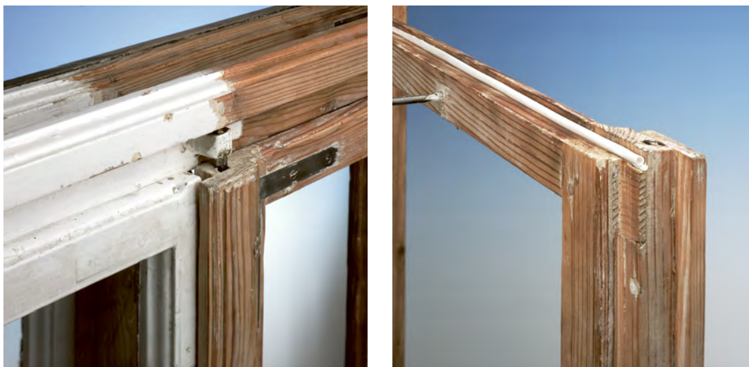
Рисунок 11: Ремонт двойной оконной рамы при помощи уплотнителя
